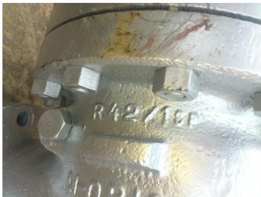
تفاوت مقدار بیرون زدگی رزوه یا هم شکل و اندازه نبودن پیچ و مهره ها به معنای باز شدن شیر (تعمیری)
