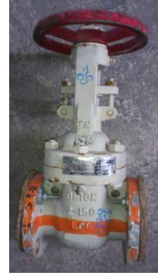
نمونه ای از رنگ یک شیر ایتالیا که از امارات وارد شده. خط نارنجی Color Code انبار امارات است
