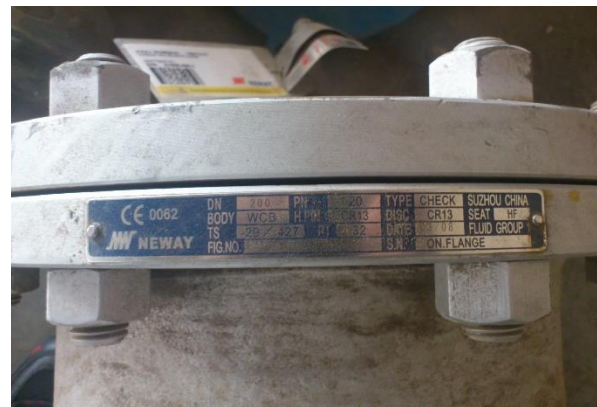
مقدار بیرون زدگی تعداد رزوه ها یکسان و پیچ و مهره یکدست به معنای این است سر شیر باز نشده (تعمیر نشده)
