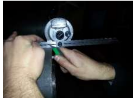
بررسی زاویه پخ اجرا شده در سر لوله با زاویه سنج
