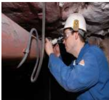
متالوگرافی از خط لوله (حین سرویس)
